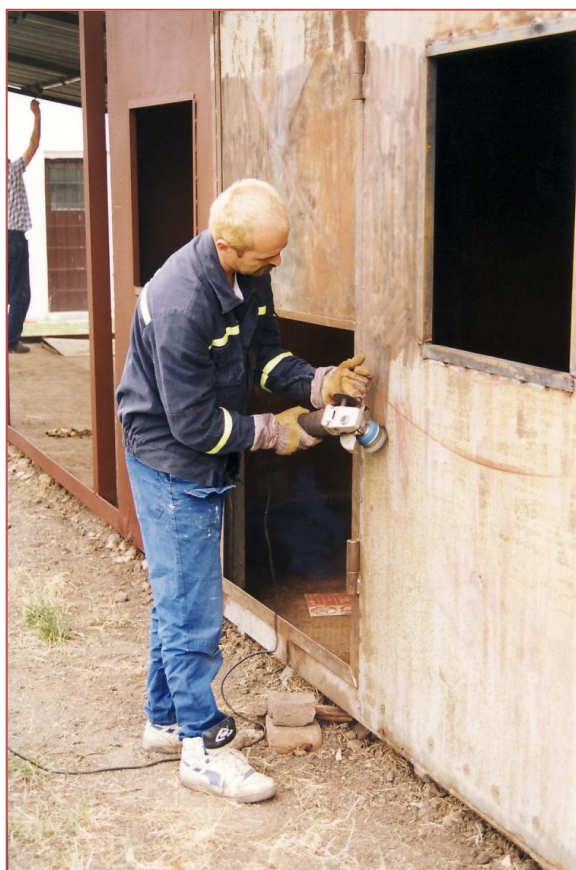
Odstrojenou konstrukci bylo potřeba očistit a natřít.
