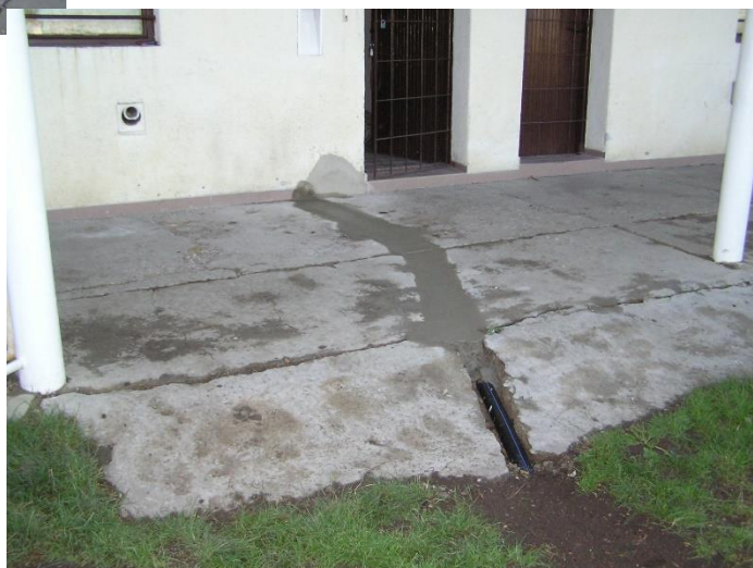
Pro budoucí automatické ovládání zavlažovacího systému bylo potřeba také přivést elektriku do kabin. K tomu bylo potřeba vysekat rýhu v betonovém chodníku.
