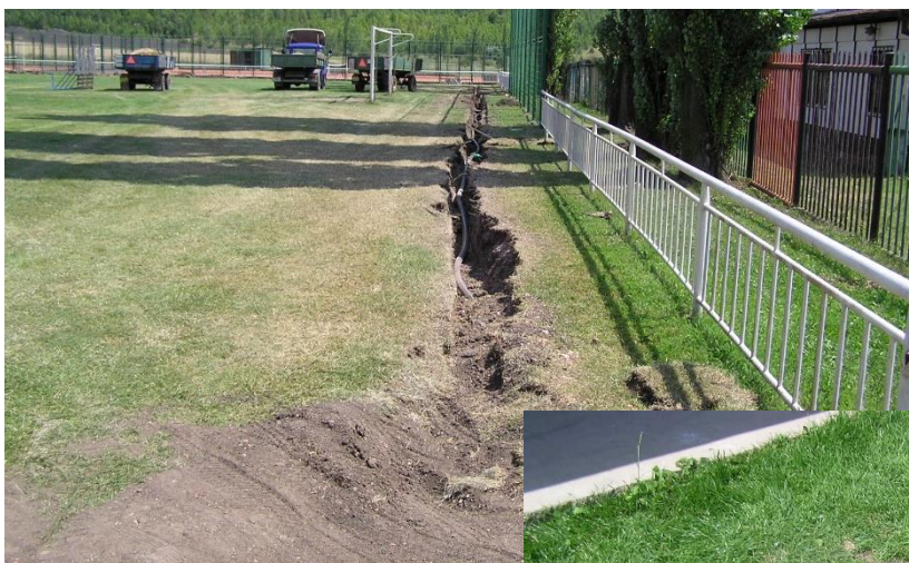
Po uložení rozvodů vody
