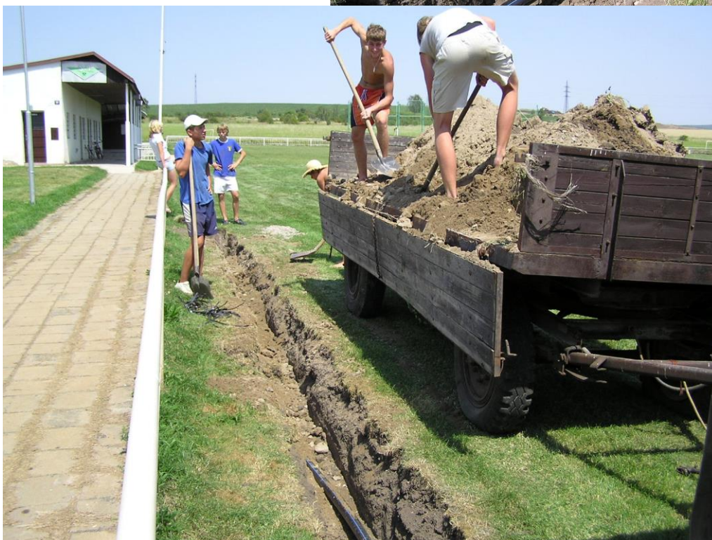
Bylo potřeba výkopy opět zaházet
